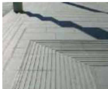
Для обеспечения безопасности передвижения слабовидящих пешеходов и интуитивно понятных направлений движения, наряду с типовыми указателями, возможно применение разно-фактурных покрытий, комбинирование различных типов укладки плитки и использование разнообразных цветов в устройстве пешеходной зоны
